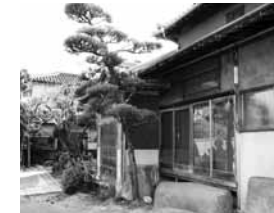
⑧河津家主屋・門
